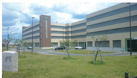
写真 2. 新青森駅西口立体駐車場
