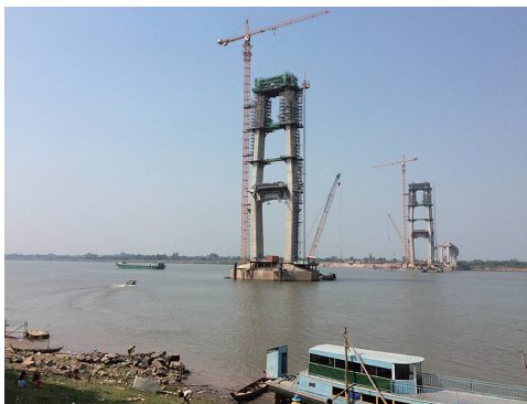
メコン川にかかるネアックルン橋。開通すればメコンの南部回廊が陸で完全に繋がる。
