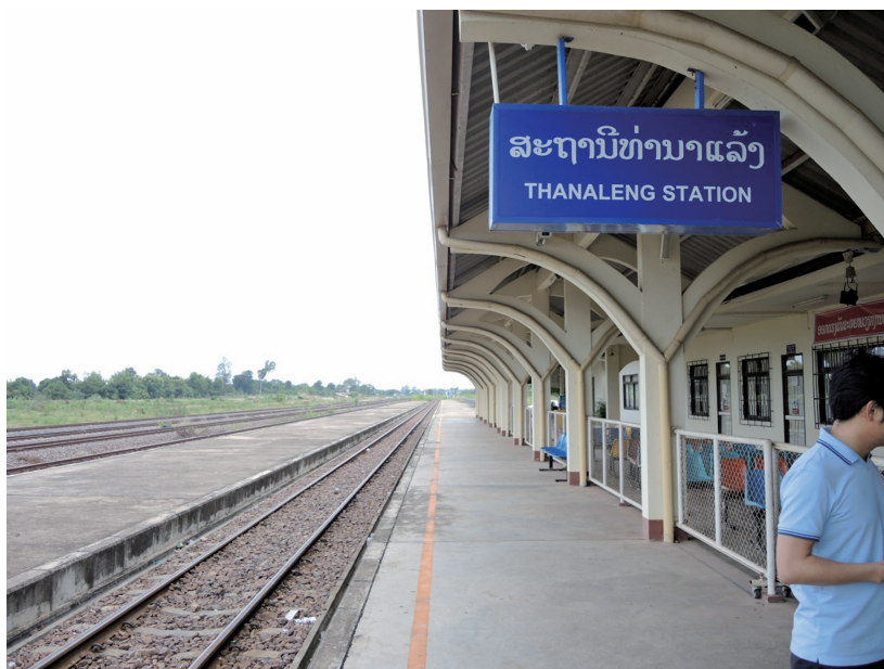
図表5 VLP 建設予定地に隣接するビエンチャン・タナレン駅
